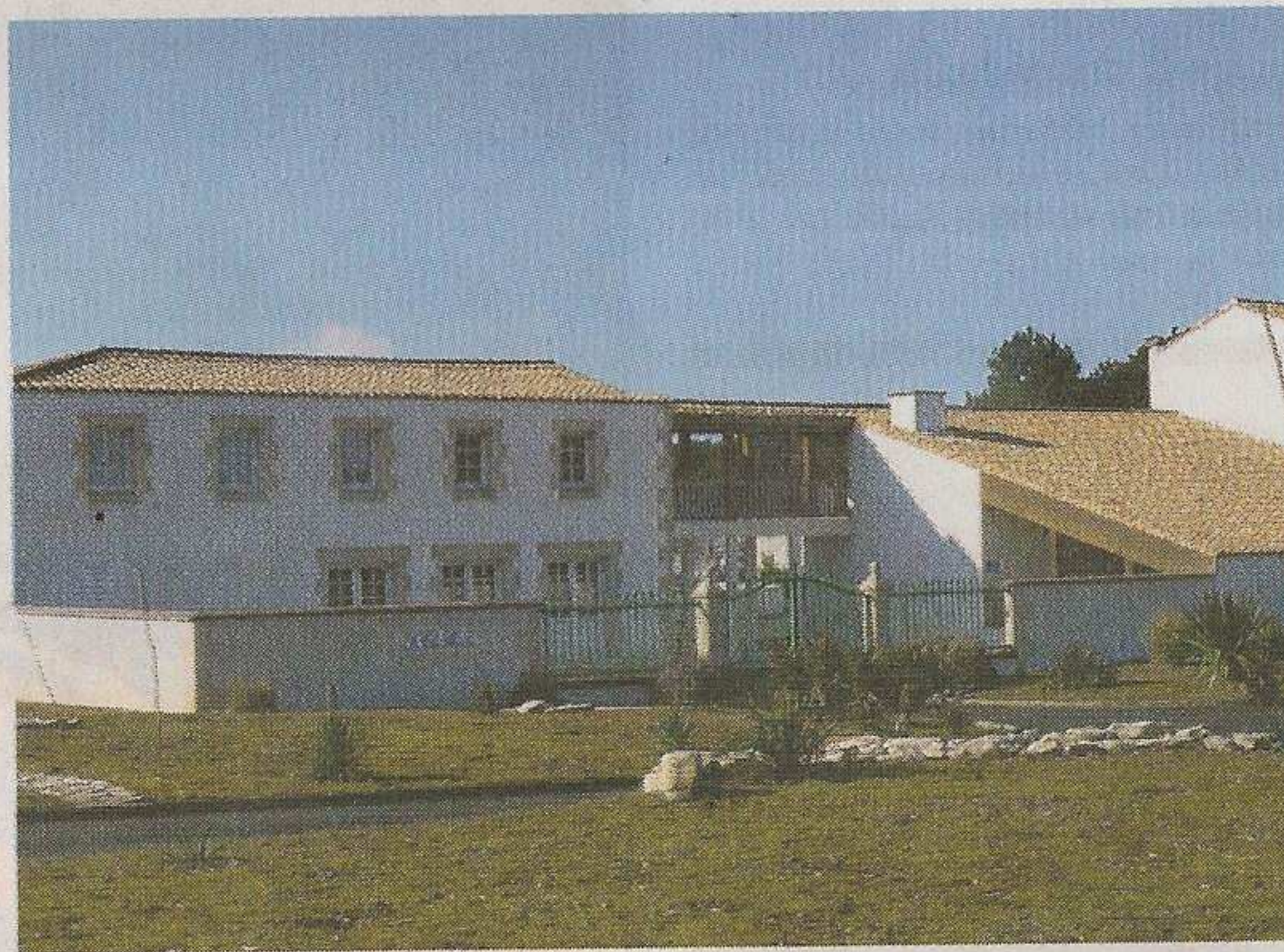
La station d'épuration de La Flotte, comme celle de Sainte-Marie, fait partie des meilleurs du département pour la qualité de ses rejets.
